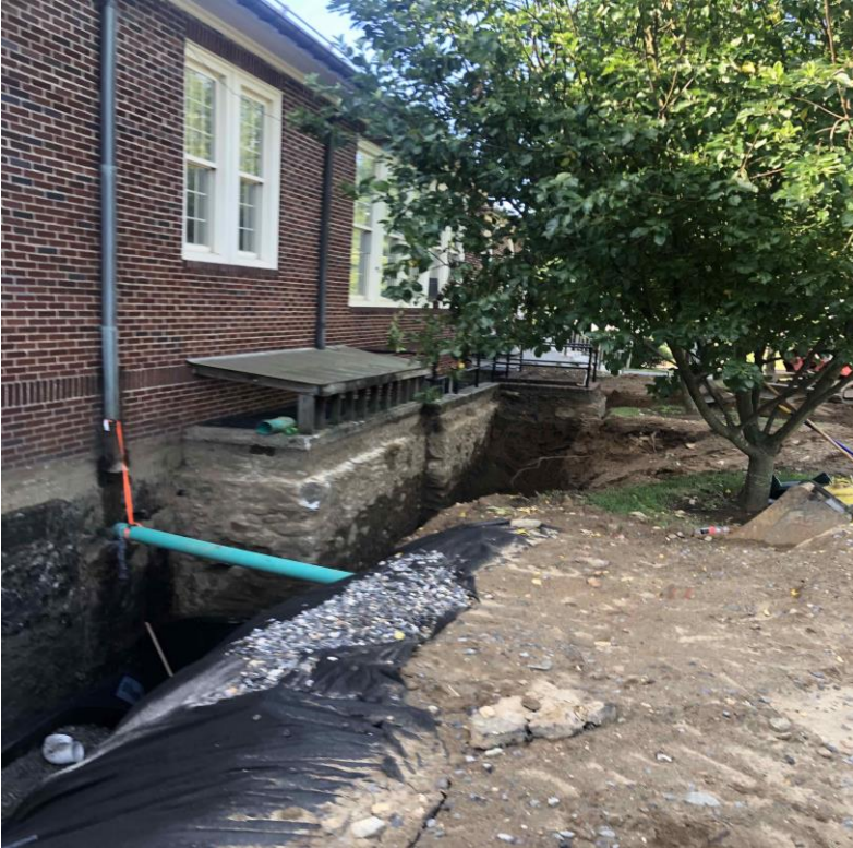
Foundation Waterproofing (E.W.)
