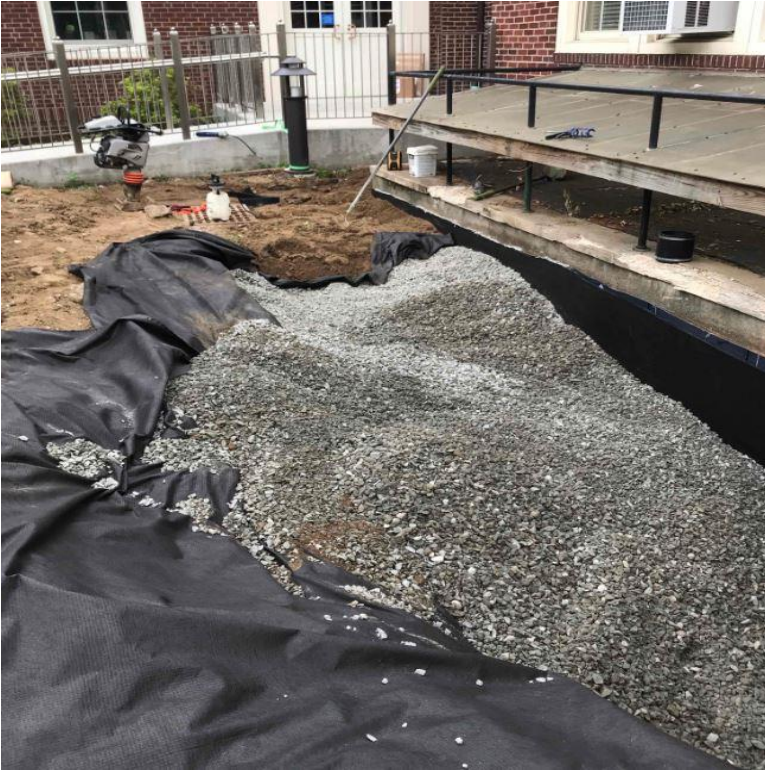
Foundation Waterproofing (E.W.)
